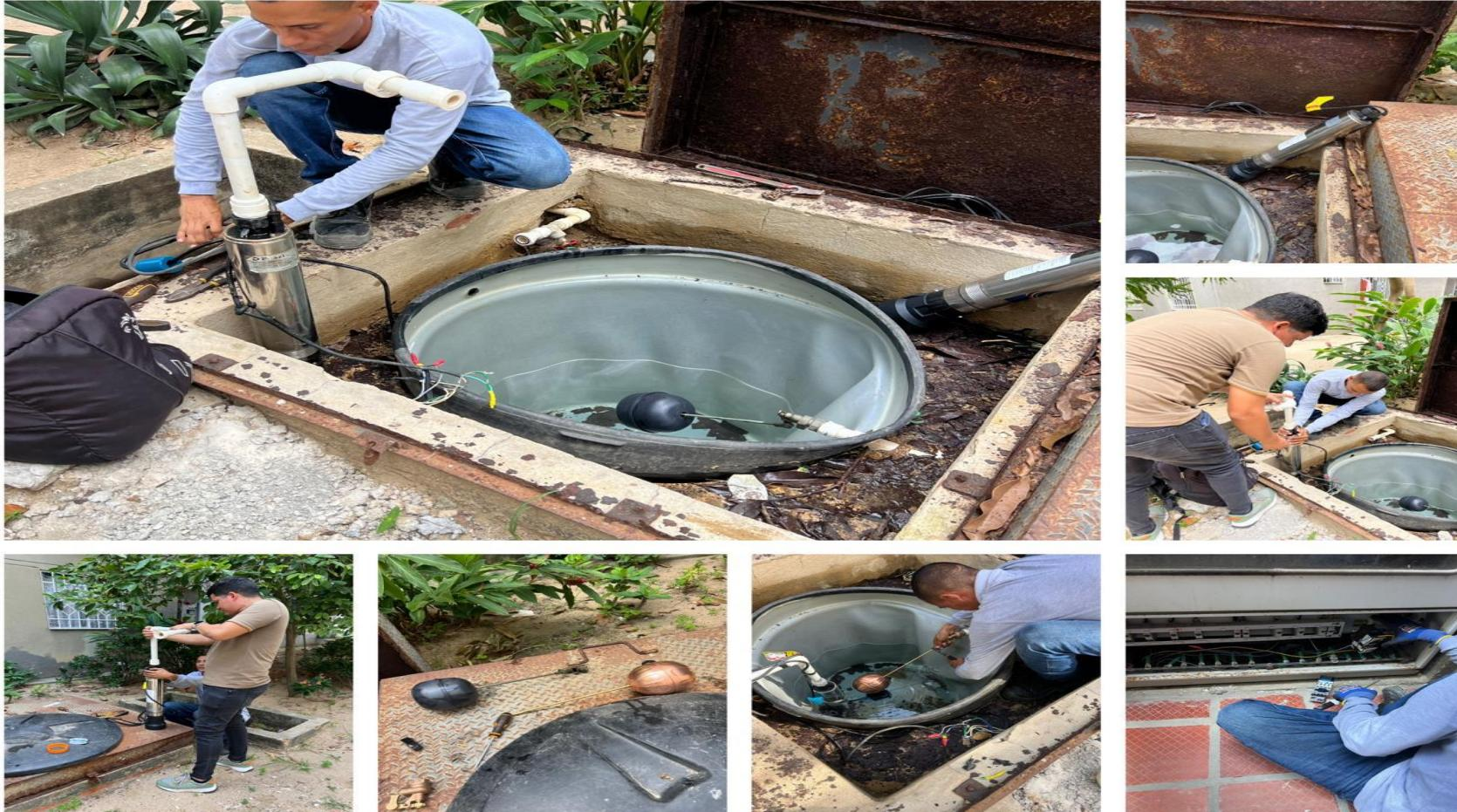
Se llevó a cabo la instalación de una motobomba en la torre 15, al igual que el cambio de válvula de llenado y cambio de contactor, esto con el fin de darle solución a la problemática presentada por el daño
