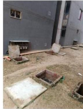
SE REALIZA EL MANTENIMIENTO CORRECTIVO DE LAS CANALETAS EXTERNAS DEL COJUNTO POR QUE SE ENCONTRABA OBTRUIDAS Y EN EL ULTIMO AGUACERO QUE PASO EL HURACAN LA ENTRADA DEL CONJUNTO DE INNUNDO
