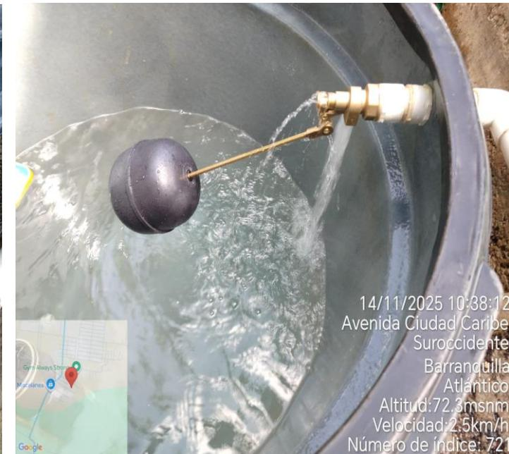
SE REALIZÓ REEMPLAZO DE VALVULA CHECK DE BOYA DEL TANQUE DE LA TORRE 1 PREVIO QUE SE ENCONTRO SIN PISTON DE SELLADO
