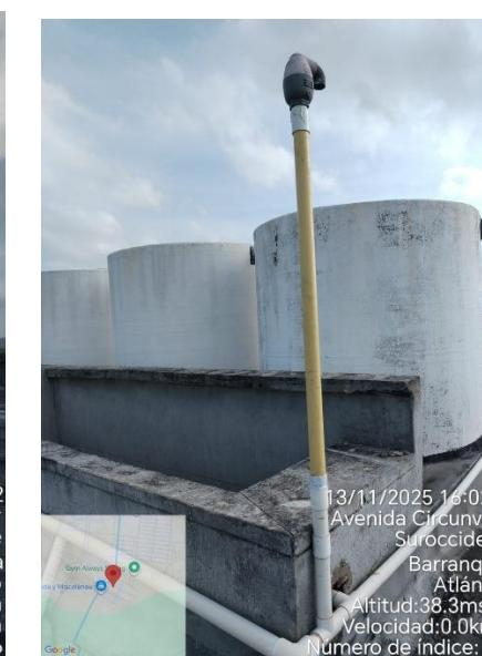
SE REALIZÓ EXTENSION DE TUBOS RESPIRADEROS DE AGUA DE LOS TANQUES ELEVADOS QUE SE ENCUENTRAN EN LA AZOTEA.
